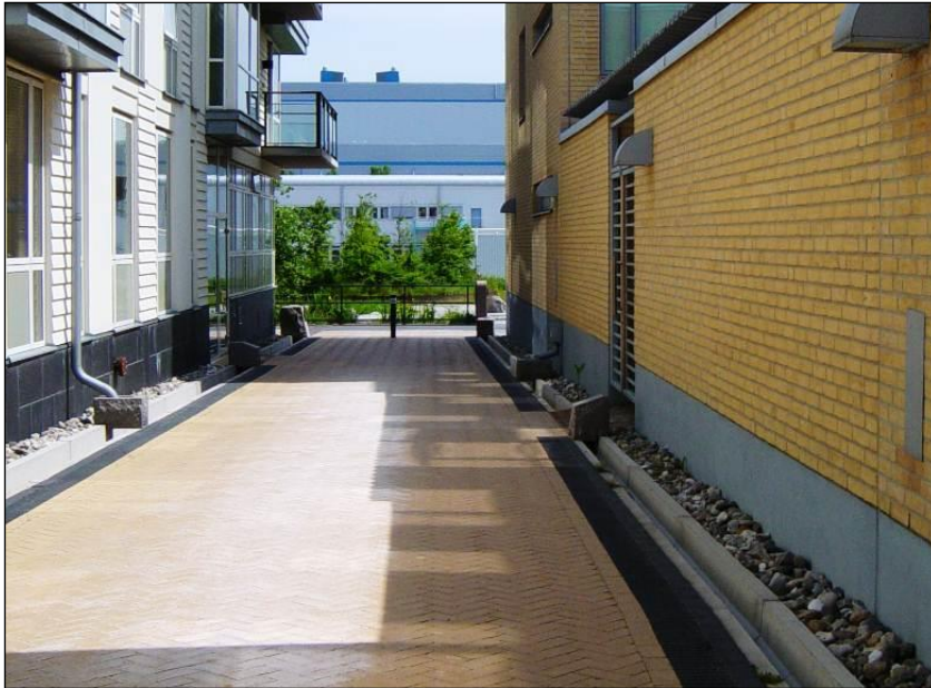
Figur 35. Stuprören anslutna till rännor för avledning av takvatten i Malmö (Foto: Emma NK)
