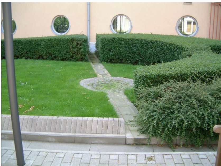
Figur 36. Exempel på ränna för avledning av takvatten i Helsingborg (Foto: Emma NK)
