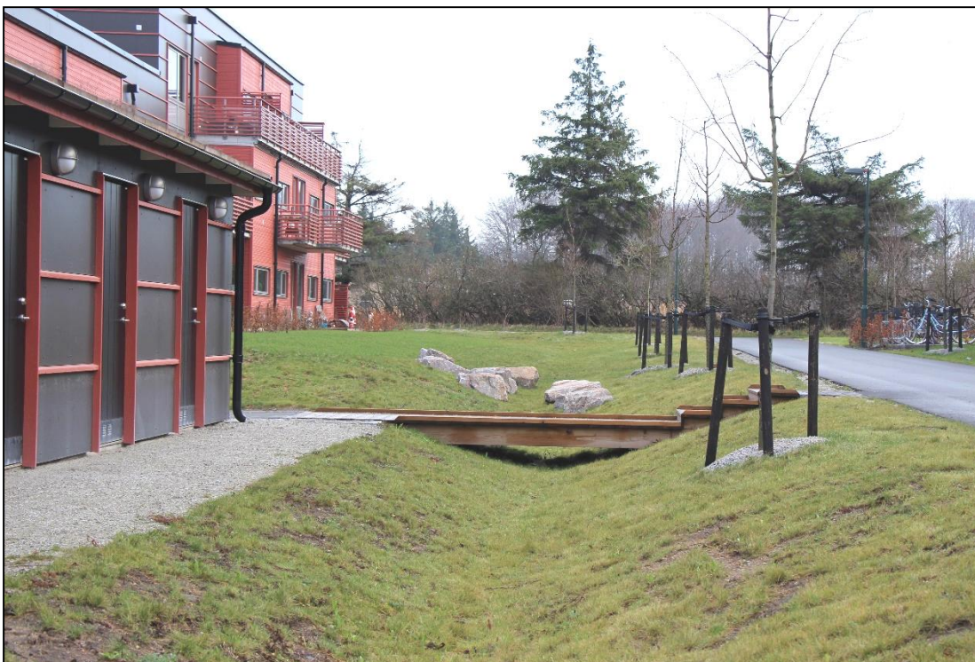
Figur 24. Exempel på svackdike i Gyllins trädgård, Malmö (Foto: Norconsult)
