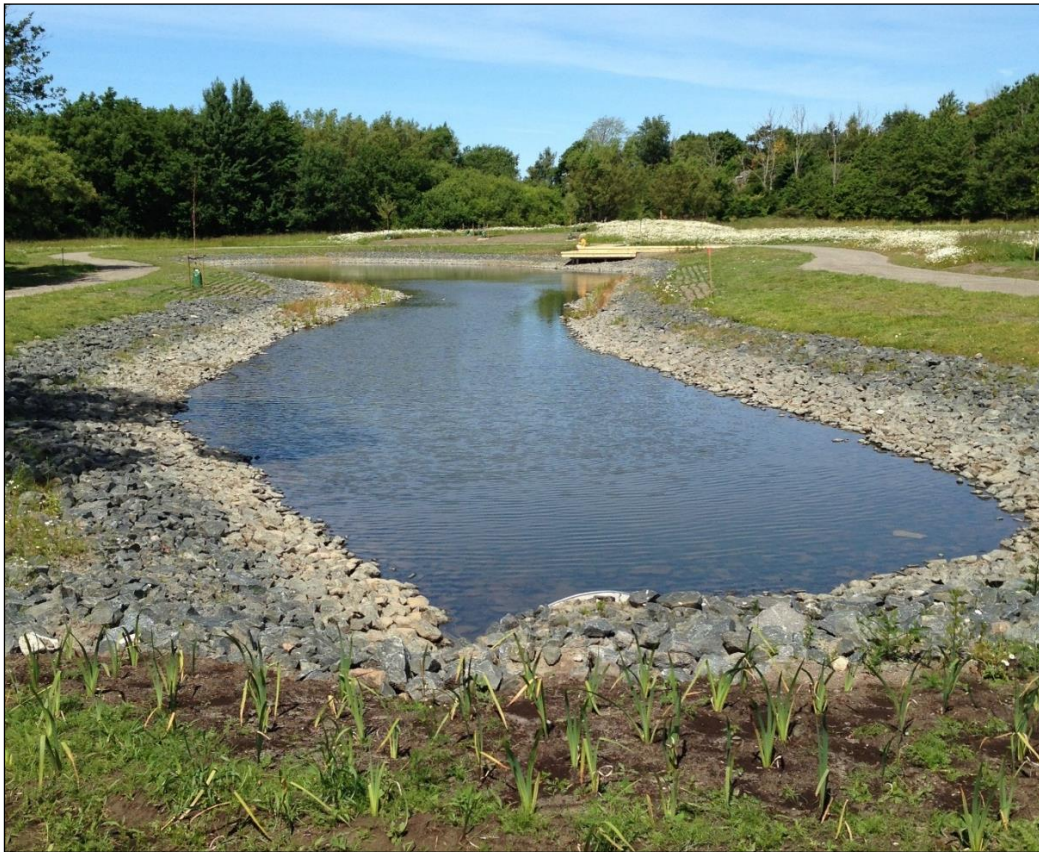
Figur 28. Exempel på dagvattendamm i Trönninge i Varberg (Foto: Norconsult)
