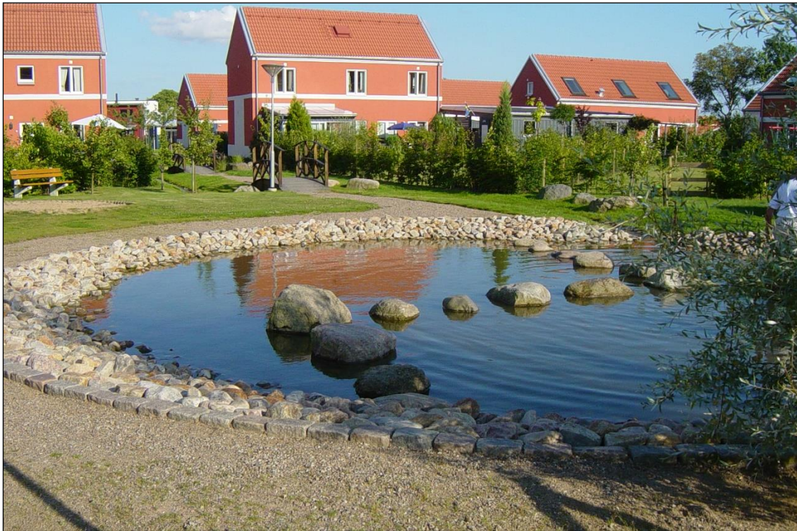
Figur 26. Exempel på dagvattendamm i bostadsmiljö i bostadsmiljö Maria Hage i Helsingborg (Foto: Emma NK)
