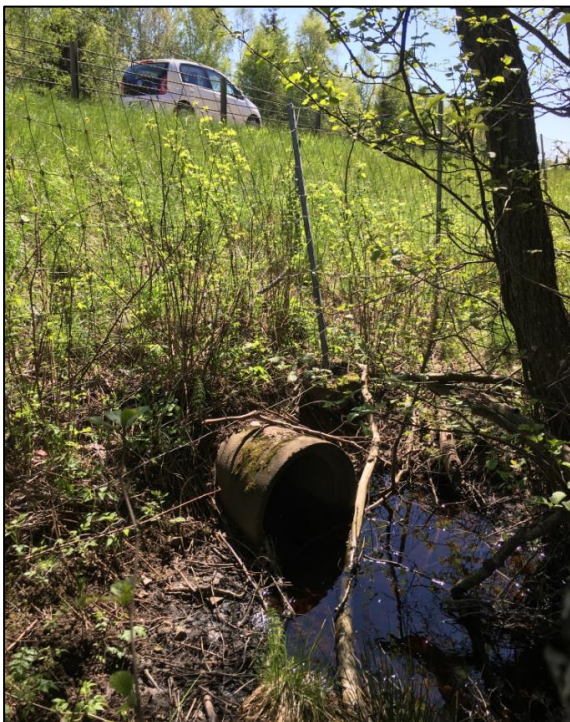
Figur 21. Avrinning från utredningsområdet sker österut mot väg E45. En del av området avvattnas via den nordligaste trumman under väg E45 (Foto: Norconsult, Britt-Inger Norlander).
